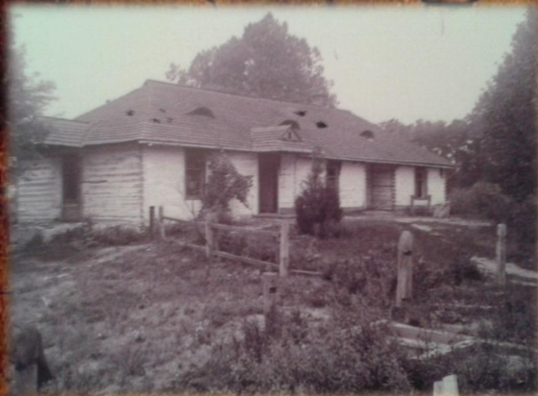
Zniszczony budynek leśniczówki w Groblach
